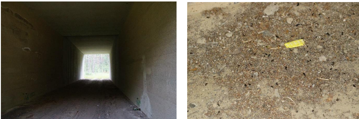
Abbildung 14: Unterführung A 11 mit Kotspuren unbekannter Fledermausart
